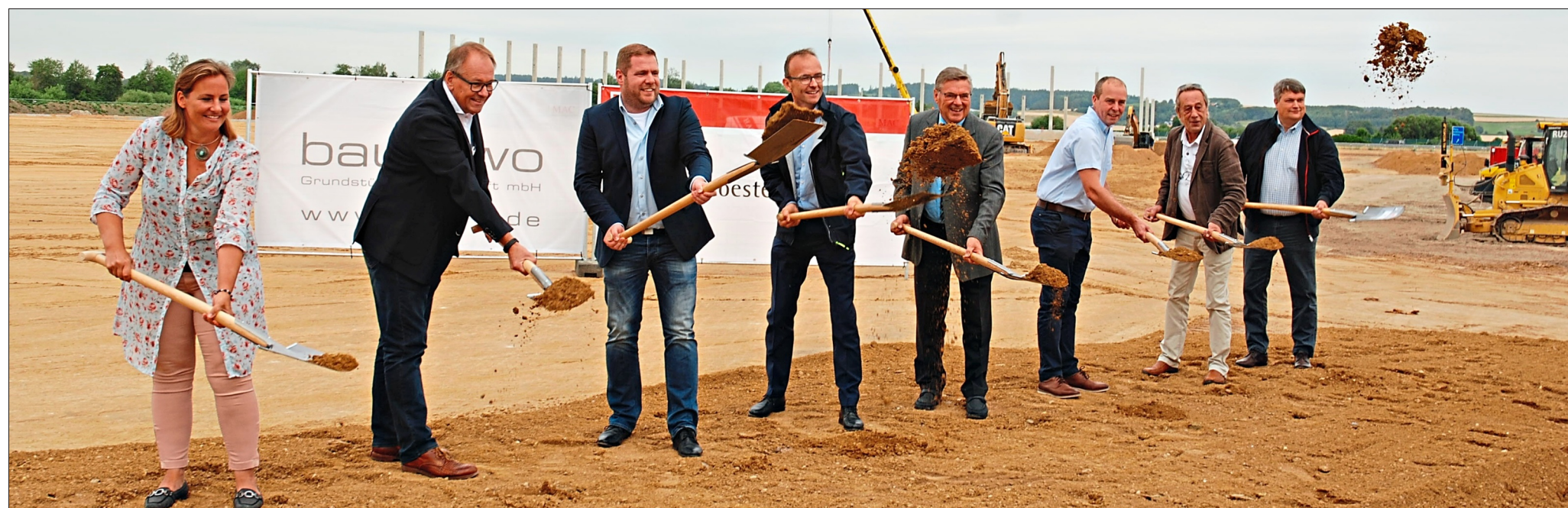
Offiziell sind die Bauarbeiten für den Gewerbepark eröffnet: Nadja Bauer-Beutlhauser (Wirtschaftsförderung, Landratsamt), Christoph Kagerer (Isarkies), Dennis Lammers (Projektleiter bauwo), Bernhard Rücker (Geschäftsführer bauwo), Bürgermeister Josef Hopfensperger, 2. Bürgermeister Martin Hiergeist, geschäftsleitender Beamter Johannes Lichtschläger und Wolfgang Holzer (hbu Immobilien) beim Spatenstich
